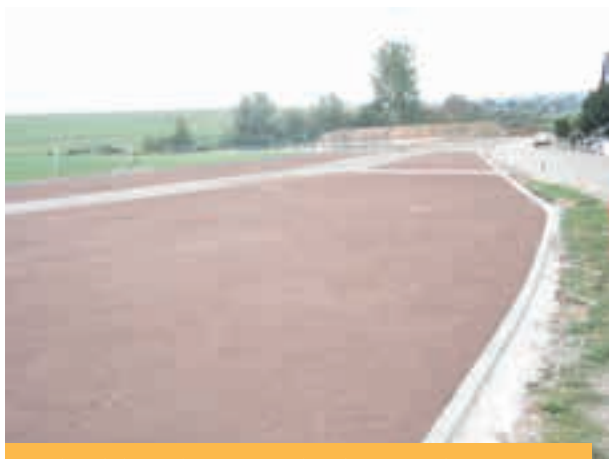
La place de la Houlette en 2009, lors des travaux d'aménagement.
